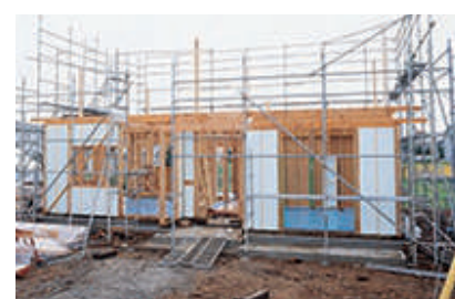
1階壁パネル施工
