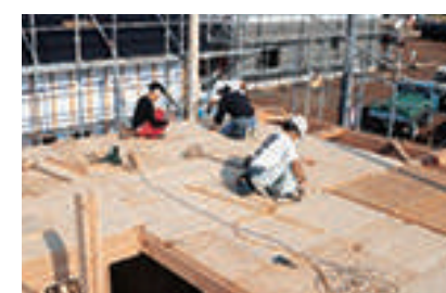
2階床パネル施工
