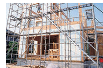
2階壁パネル施工
