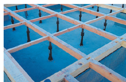
1階床組(土台)施工
