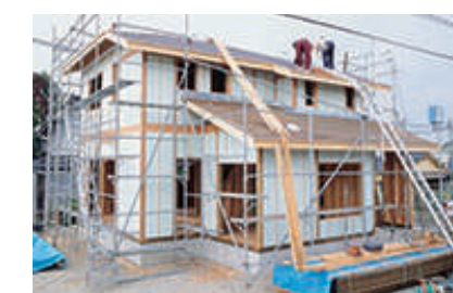
屋根材・サッシ粋施工
